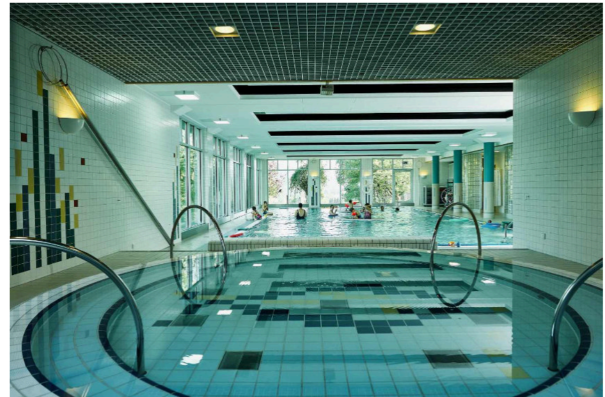
Komplettsanierung des Schwimmbereichs
